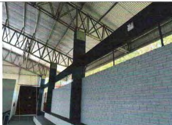
LUMINÁRIA DE EMERGÊNCIA
