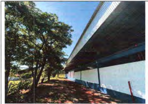
FECHAMENTO LATERAL EM TELHA METÁLICA
