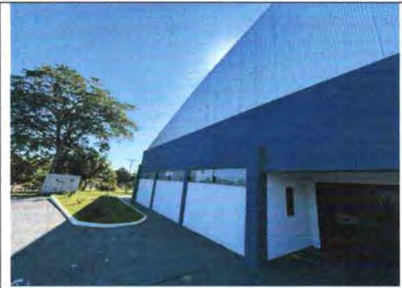
EMBONECAMENTO DE TUBOS, REBOCO PILARES
