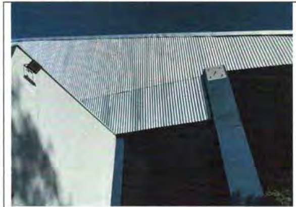
FECHAMENTO EM TELHA METÁLICA
