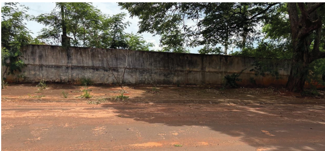
Imagem: Muro a ser demolido sem reaproveitamento.
