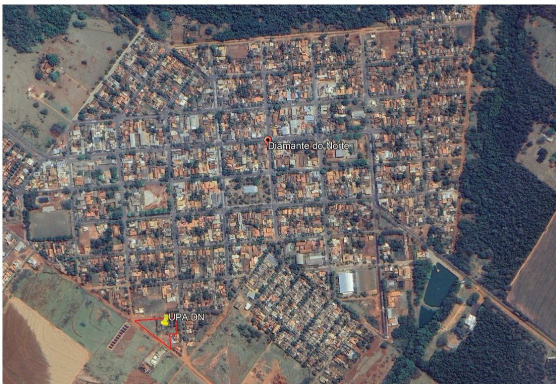
Imagem: Localização da edificação
