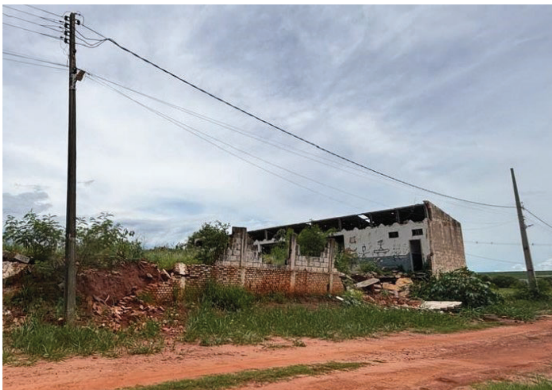
Imagem: Edificação a ser demolida sem reaproveitamento.
