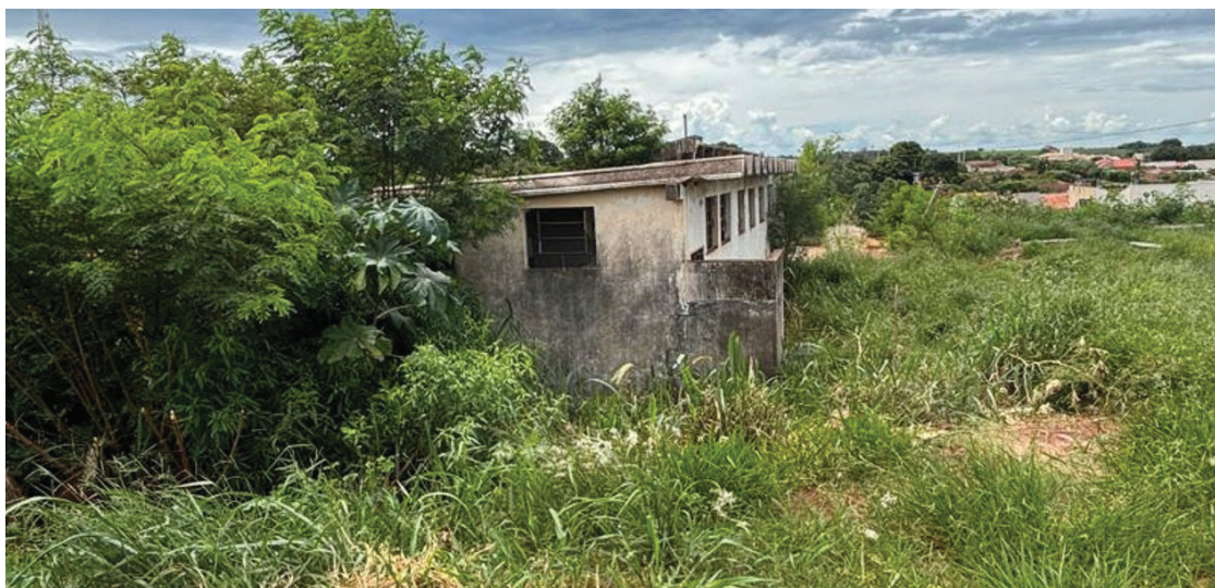
Imagem: Edificação a ser demolida sem reaproveitamento.
